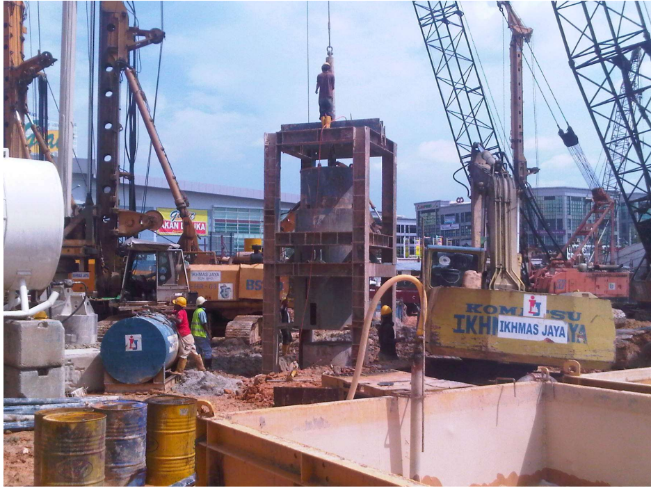
图10——动态桩基载荷试验的执行
