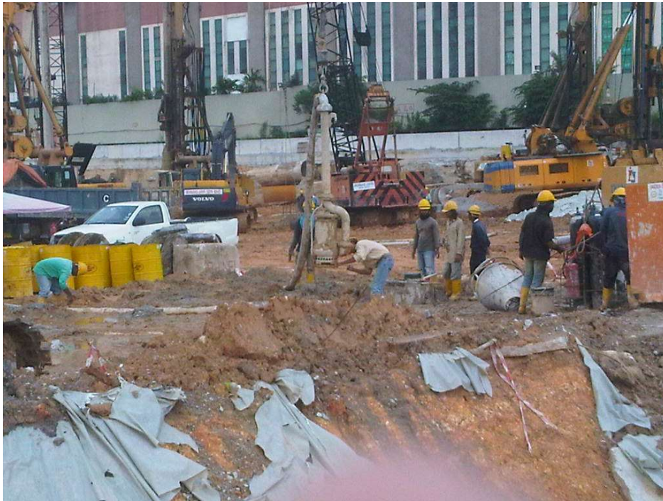
图 7——护壁液回收泵定位
