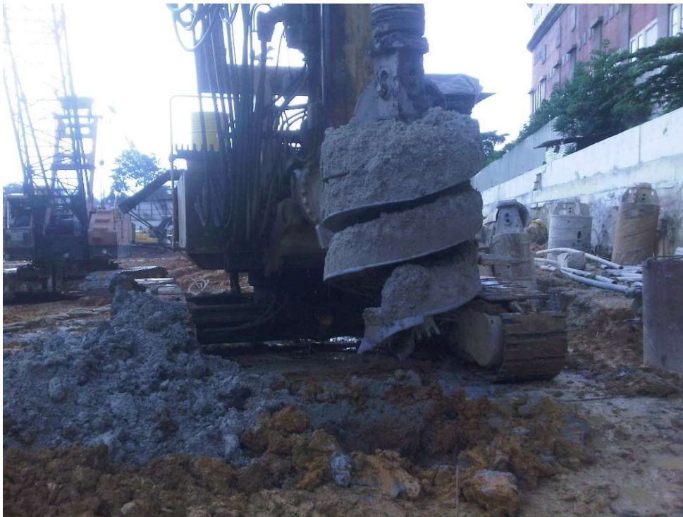
图 3——在套管深度内取土
