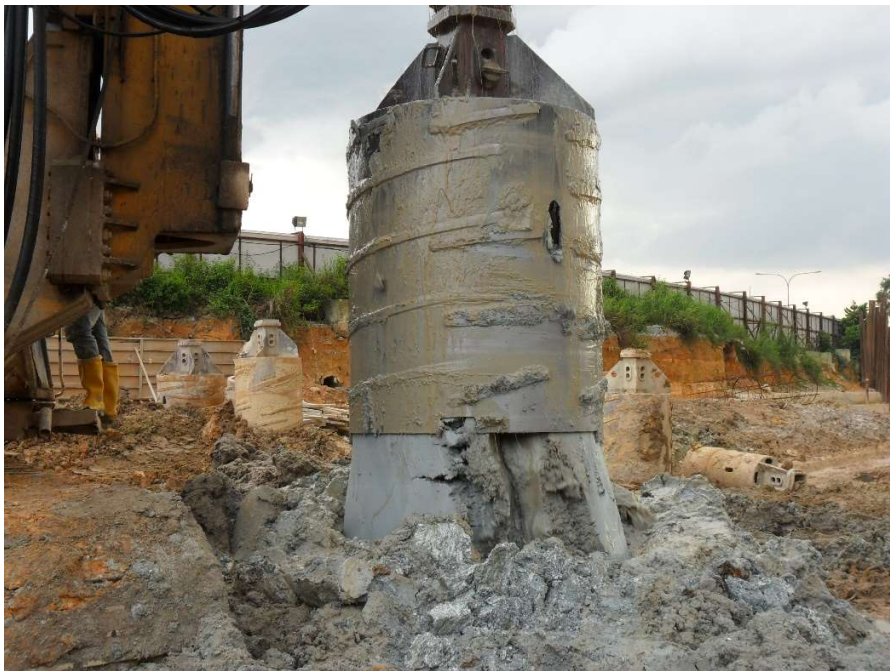
图12——使用G3新型护壁液取回的土壤呈干性状态
