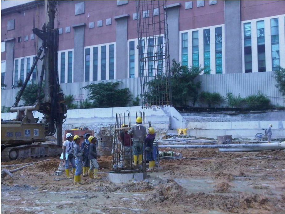
图 6——设置钢筋笼
