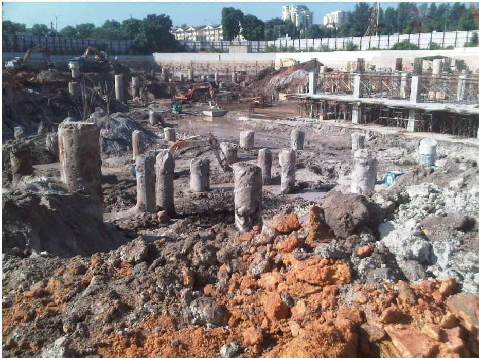
图11——采用G3系统施工后等待破除桩头的现场情况
