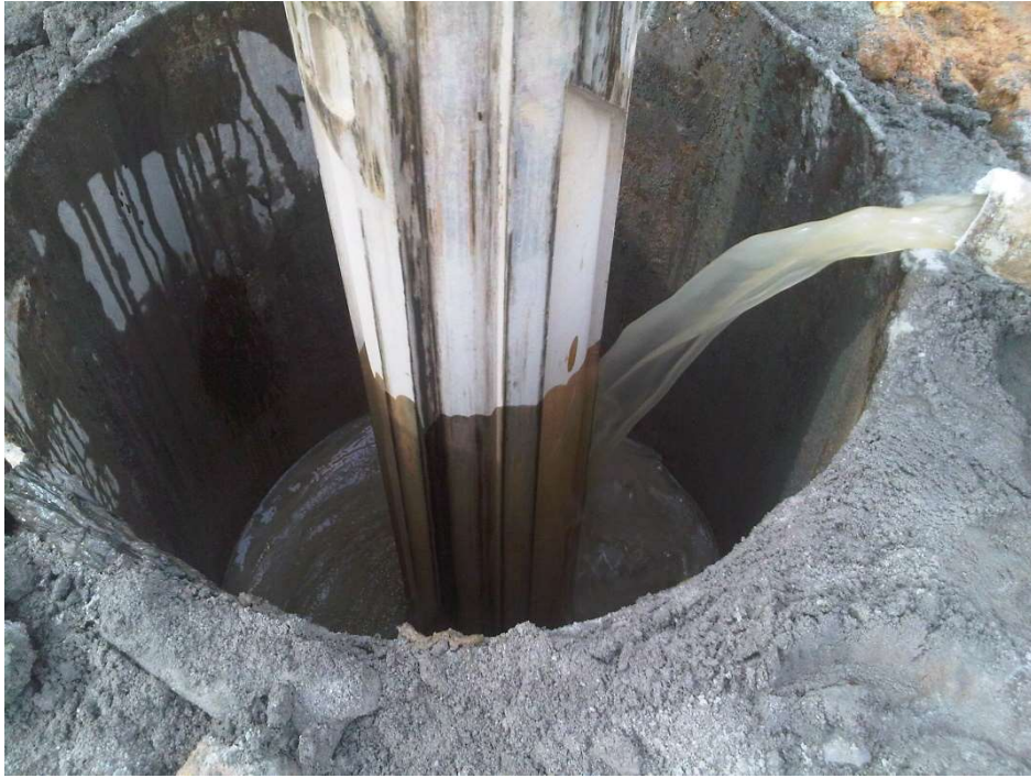
图 4——开挖初期添加 PolyMud（G3 新型护壁液组分）
