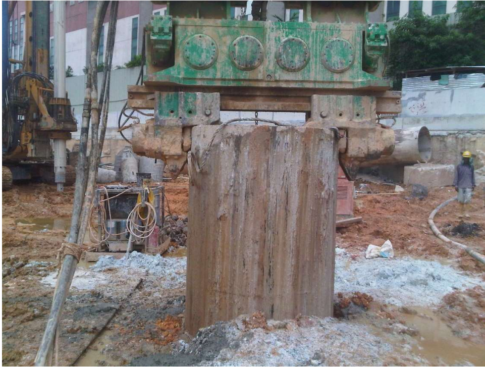
图 2——导向套管定位
