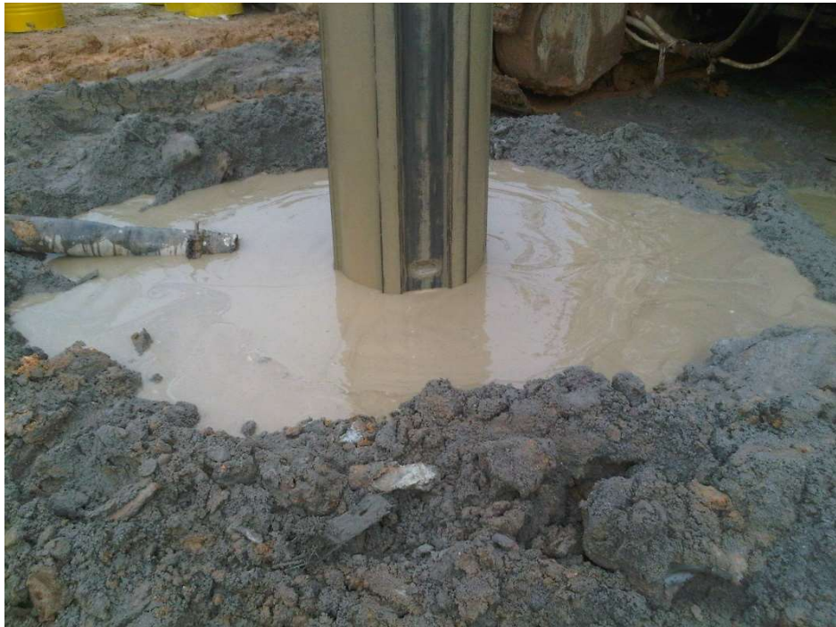
图 5——补偿液位增加静水压力
